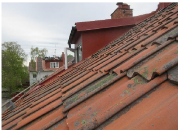
Yttertaket belagt med lertegel
