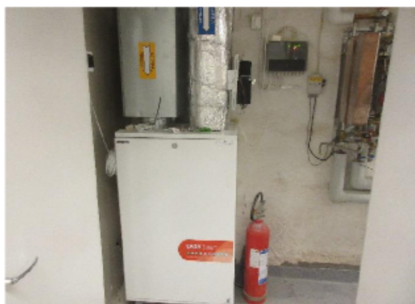
Ventilationsaggregatet för källarplan
